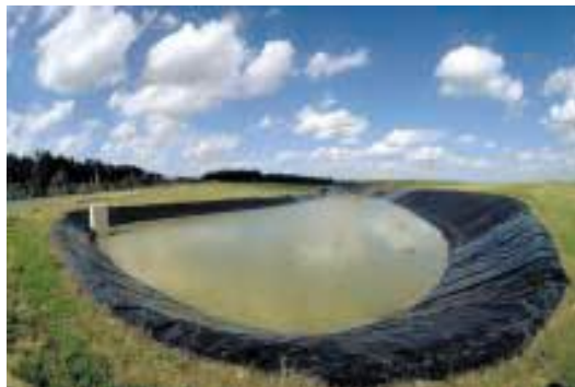
Bassin de rétention sur l'aérodrome
