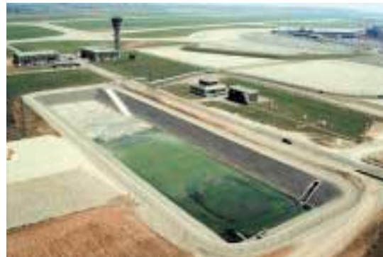
Bassin de décantation sur l'aérodrome
