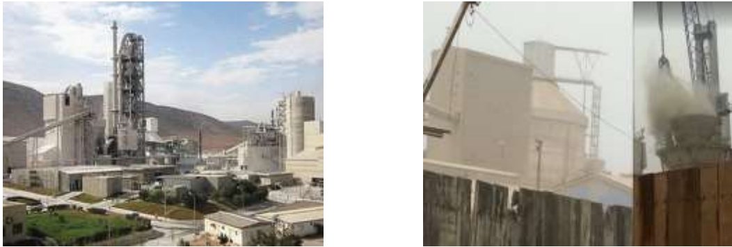
Figure 15 : Atmosphères poussiéreuses des cimenteries de Beni-Saf (Algérie) et d'Abidjan (Cote d'Ivoire)
