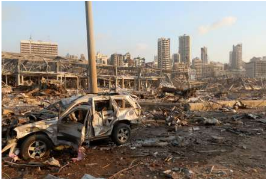
Figure 1 : Double explosions du port de Beyrouth due à la négligence lors du stockage du Nitrates d'ammonium
