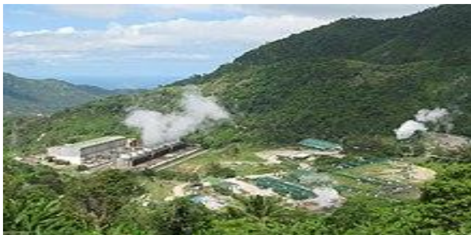
Figure n°7 : La centrale géothermique de Palinpinon (Philippines), le plus profond puits est de 3 800 m ( Webmaster 11 )
